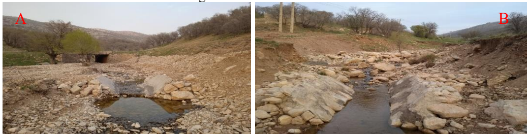
شکل ۳- کانال احداث شده در خروجی زیرحوضه جنوبی (A) و شمالی (B)
