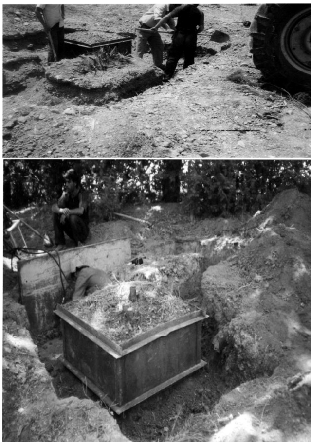
تصویر ۲-الف و ب: طرز قرار گرفتن جک و صفحه فولادی
