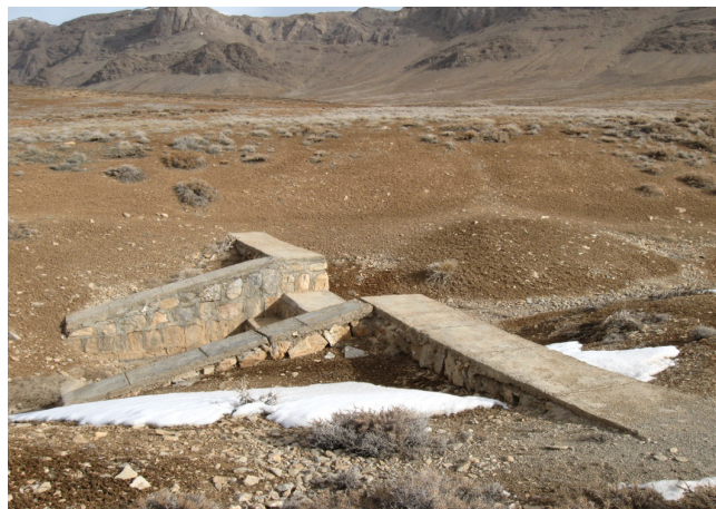
شکل ۳- نمای کلی از بند شماره ۶ در آبراهه اصلی
