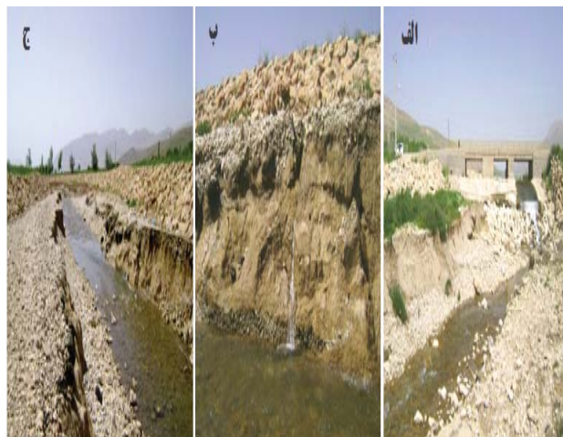
شکل ۱- نمایی از وضعیت موجود رودخانه خشکه رود؛ الف) پل عیسی آباد، ب) اثر تراوش آب و ج) رسوبات حساس به فرسایش.
