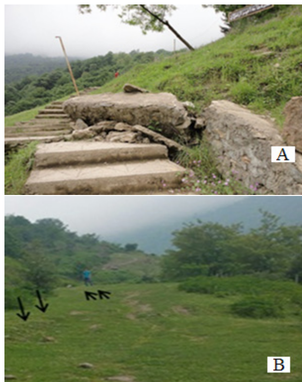
شکل ۱۴- (A) اثرات جابجایی در فعالترین قسمت لغزش که پله‌ها را تخریب نموده است، بخش تراسه‌ای (محدوده قرمز در شکل ۱۰) (B) اثرات جابجایی در محدوده نقطه مثلث مشکی Fig 14. A) displacement in most active part of landslide destroyed buildings, terraces part (red polygon in Fig10) B) Displacement traces in black triangle point area
