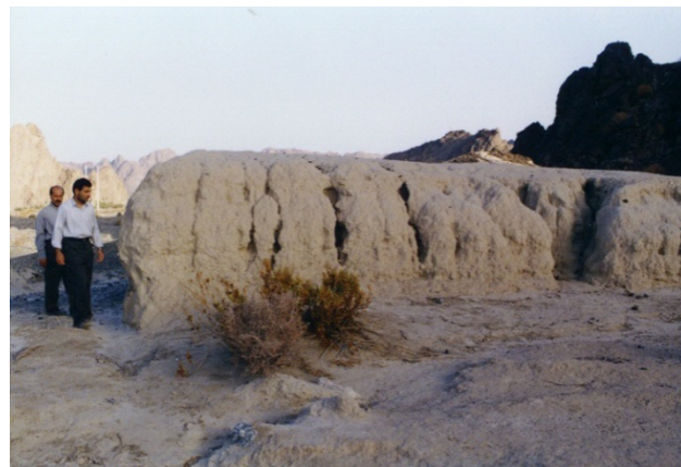
شکل ۷- ضخامت رسوبات نهشته شده در یک خوشاب (روش سنتی استحصال سیلاب) متروک در بلوچستان Figure 7. The thickness of sediment deposited in an destroyed Khushab (an indigenous flood harvesting method) in Baluchistan
