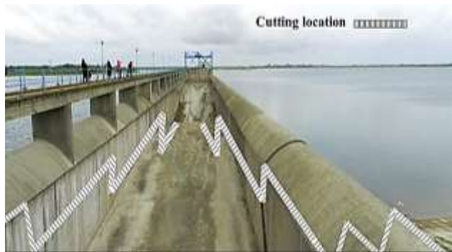
شکل ۴- حذف سد به روش پله ای بر روی سرریز سد وشمگیر Fig 4. Stepped dam removal of Voshmgir Dam spillway
