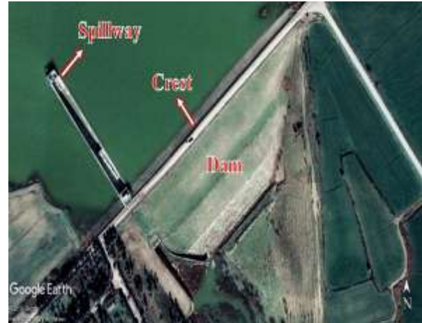
شکل ۲- سد و سرریز سد وشمگیر
