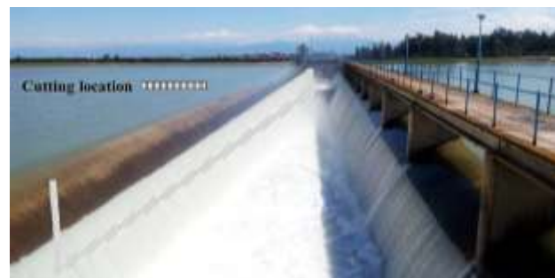
شکل ۵- حذف جزئی سد از سرریز سد وشمگیر Fig 5. Cutting location of the Vashmgir Dam spillway
