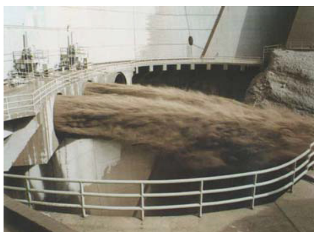
شکل ۲- تخلیه‌کننده‌ها در زمان باز شدن جهت رسوب‌شویی تحت فشار (سد دز - خوزستان)
